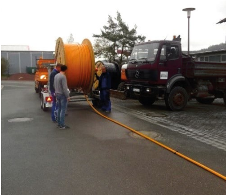
Abwickeln SRV-G tc von der Spule
