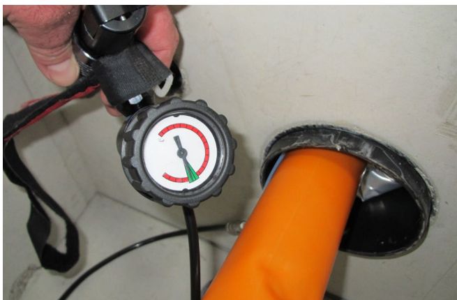
Füllen und Abdichten des „TE Connectivity ADE / TDUX“
