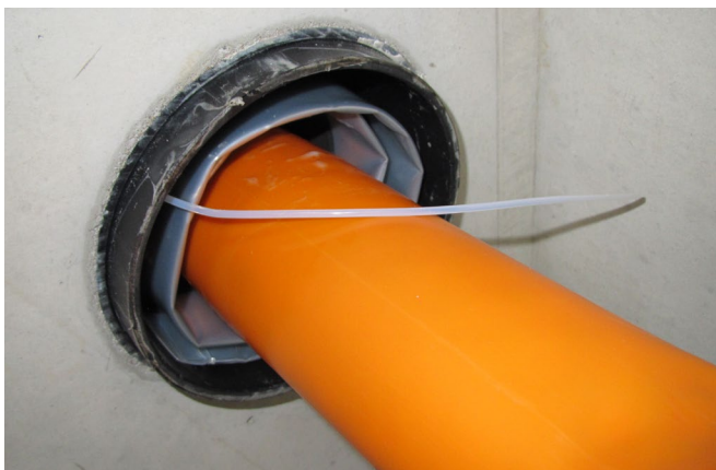
Gemeinsame Montage des „TE Connectivity ADE / TDUX“ in das KKR
